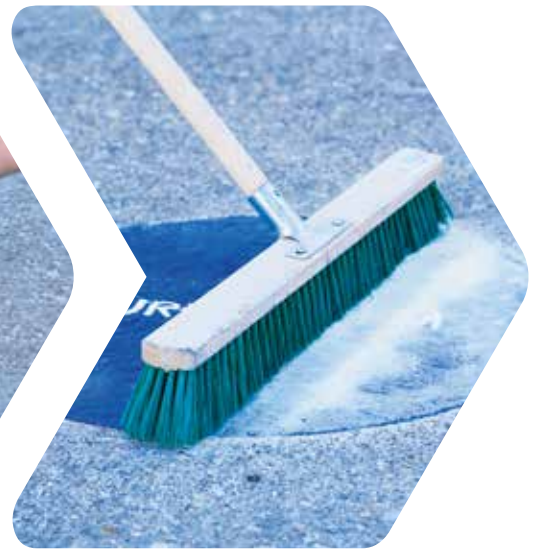
EUROTHERM mit dem Besen reinigen und die Haftung mit einem spitzen Gegenstand prüfen. Schon nach wenigen Minuten ist die Markierung befahrbar.
